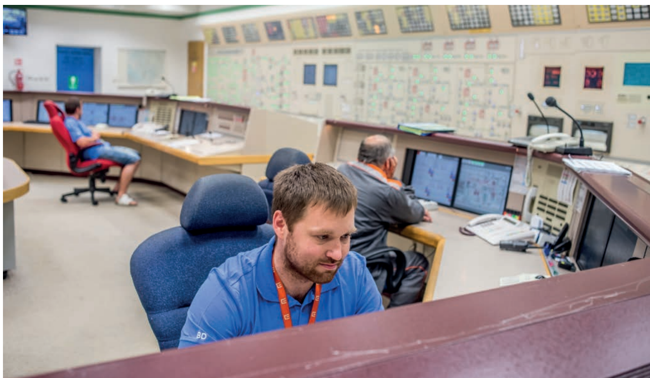
V jaderné elektrárně Temelín pracuje na šest desítek operátorů. Provoz elektrárny řídí směnový inženýr z budovy ústřední elektrické dozory, a to za spolupráce dalšího personálu, především pracovníků dozoren jednotlivých jaderných bloků.
