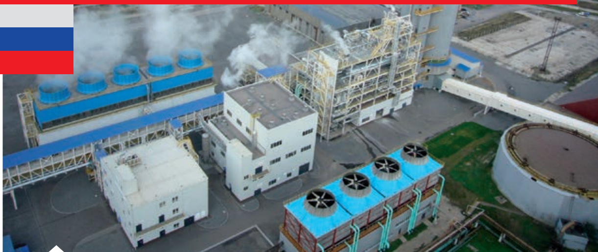
ZÁVOD ČEREPOVEC 1, KTERÝ CHEMOPROJECT NITROGEN REALIZOVAL V MINULOSTI. VEDLE VĚŽE NAPRAVO NYNÍ ROSTE NOVÁ JEDNOTKA GRANULACE
