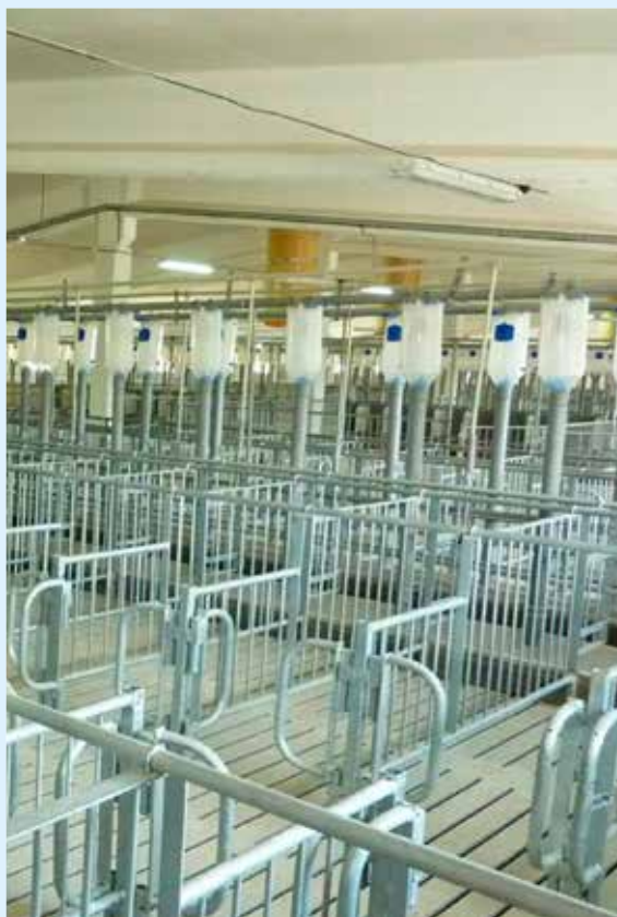
BAUER TECHNICS – VÝSTAVBA KOMPLEXU DVOU FAREM NA VÝKRM PRASAT
