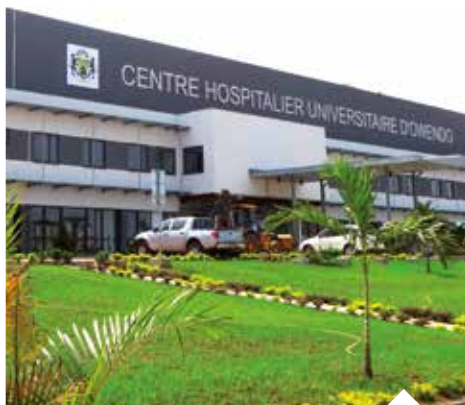
REALIZOVANÁ NEMOCNICE V GABUNU
