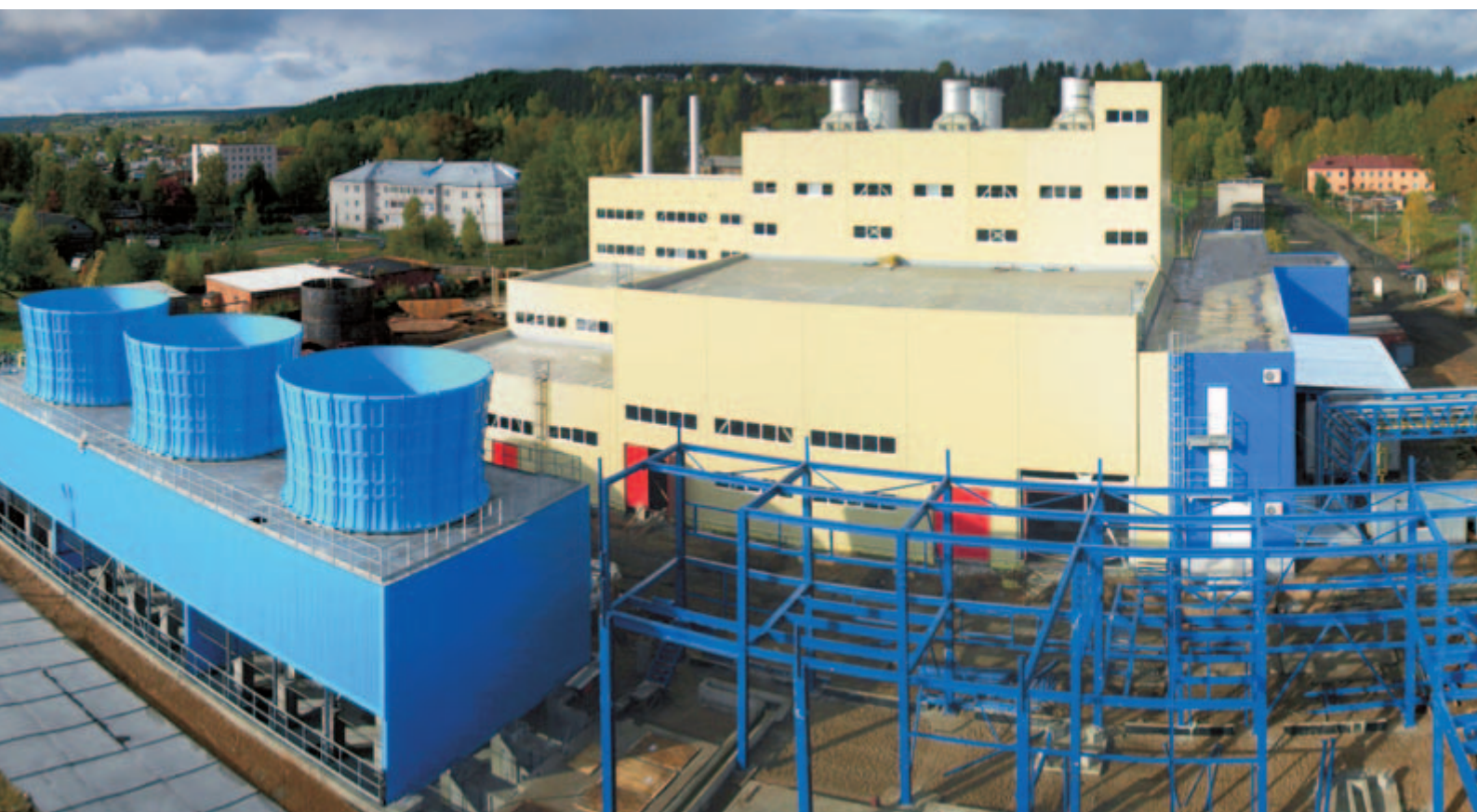
| Výstavba elektrárny Krasavino, Ruská federace. Dodavatel: PSG-International a.s.
