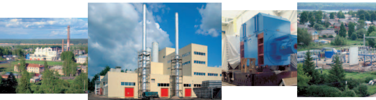
| Výstavba elektrárny Krasavino, Ruská federace. Dodavatel: PSG-International a.s.
